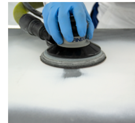
uma vez que a cor preta é coberta, pode-se também ter certeza da espessura necessária para o primário.
